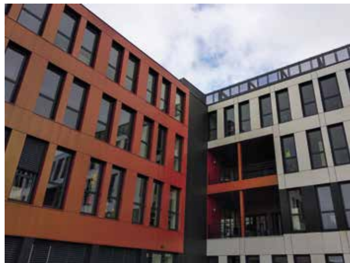
Le bâtiment du Campus Cougnaud, a contribué à définir la norme RE 2020.
